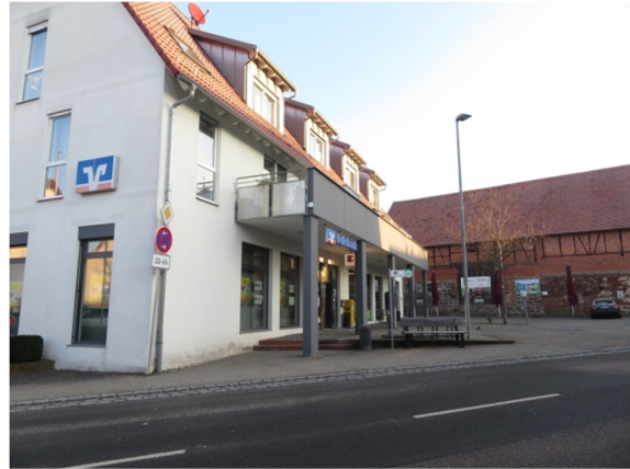
Foto 2: Tante M-Markt Unterheinriet - Gebäudeschrägansicht
